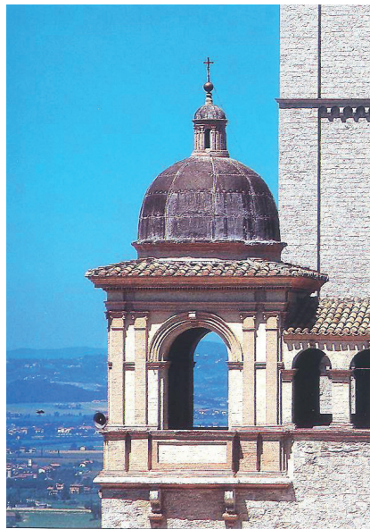
Figura 14 - Torre encimada por uma cúpula hemisférica, ao lado esquerdo da fachada do Conjunto Basilical Superior.
