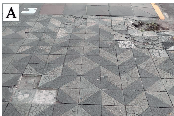
Figura 1 - Falta de lajotas nas calçadas
