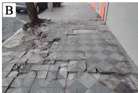
Figura 1 - Falta de lajotas nas calçadas
