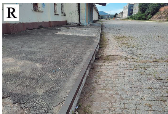
Figura 9 - Falta de rebaixamento das calçadas
