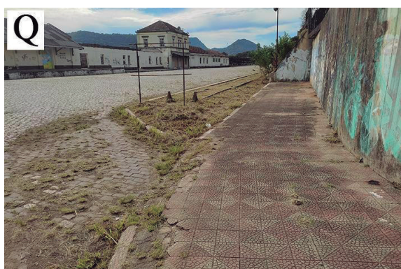
Figura 9 - Falta de rebaixamento das calçadas
