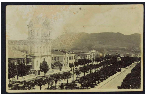
Figura 2 - Vista da Avenida Progresso, atual Avenida Rio Branco, e seu Canteiro Central. À esquerda, a Catedral, entre 1929 e 1930.
