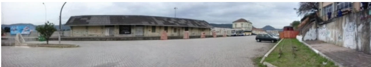
Figura 5 - Estação Ferroviária de Santa Maria - Gare, 2013.
