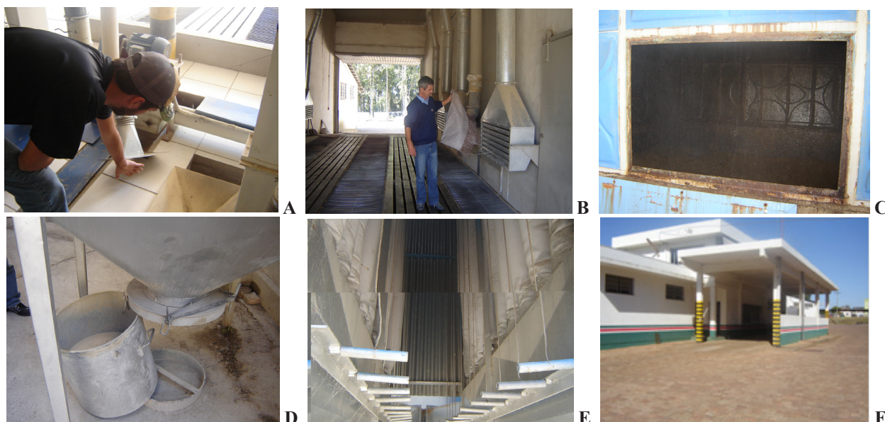
Figura 2 - Filtros de manga e ciclones em todas as máquinas de pré-limpeza e limpeza (A), exaustores das moegas (b); lavador de gases (c); coletor de pó (d); filtros (e); pesagem e amostragem de grãos(f).
