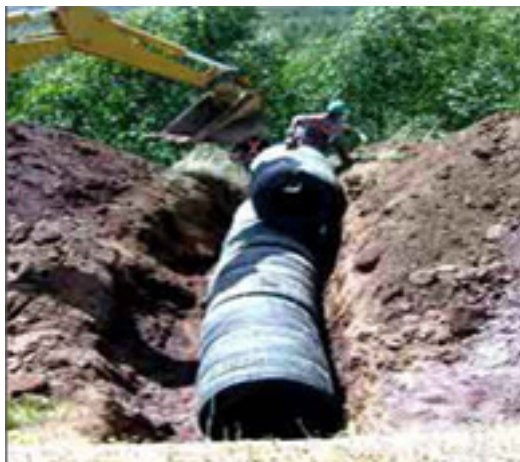
Figura 3 - Eccoduto sendo instalado para canalização de esgoto.
