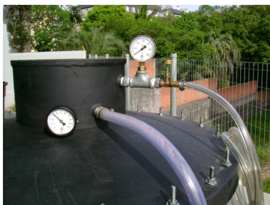
Figura 2 - Tampa do biodigestor construído no Laboratório de Engenharia Ambiental do Centro Universitário Franciscano – UNIFRA, com acessórios. Santa Maria, RS, 2009.
