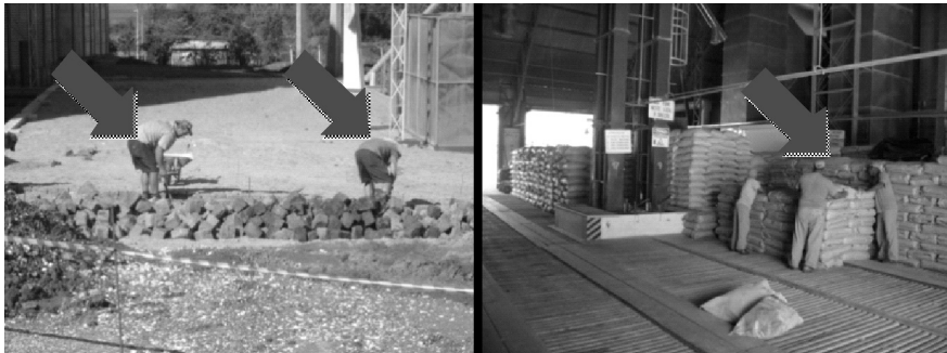
Figura 3 - Serviços de reforma e descarga de caminhões
