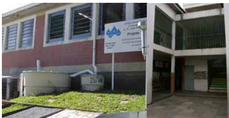
Figura 1. Fachada frontal da escola e vista dos prédios em estudo.
