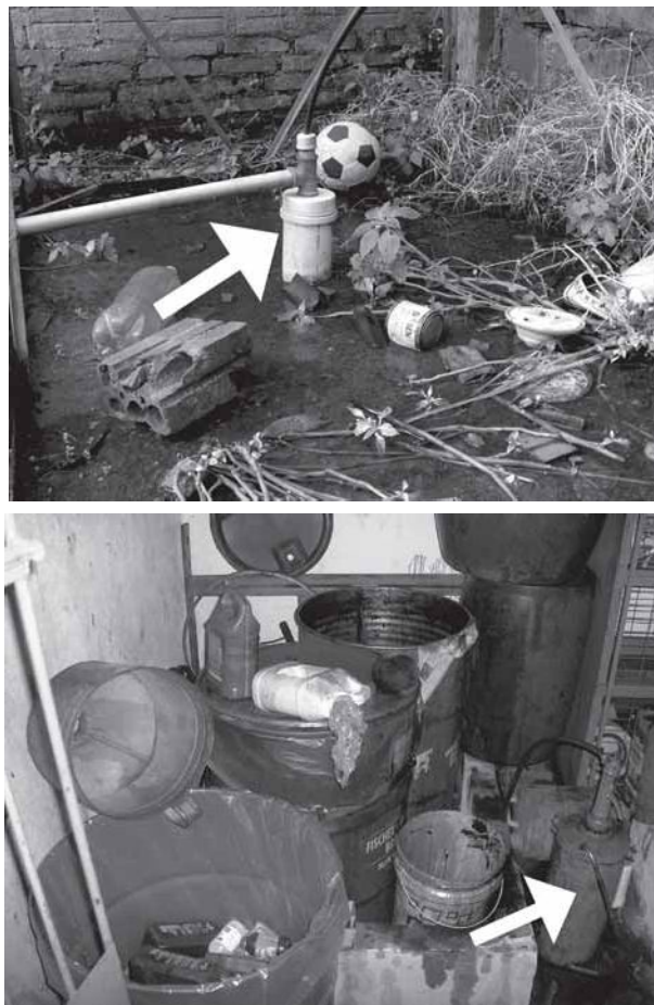
Figura 9. Situação de dois poços tubulares sem manutenção.
