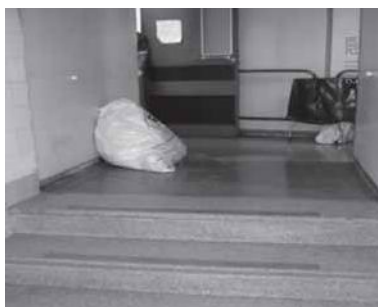
Figura 2. Depósito de resíduos no corredor.
