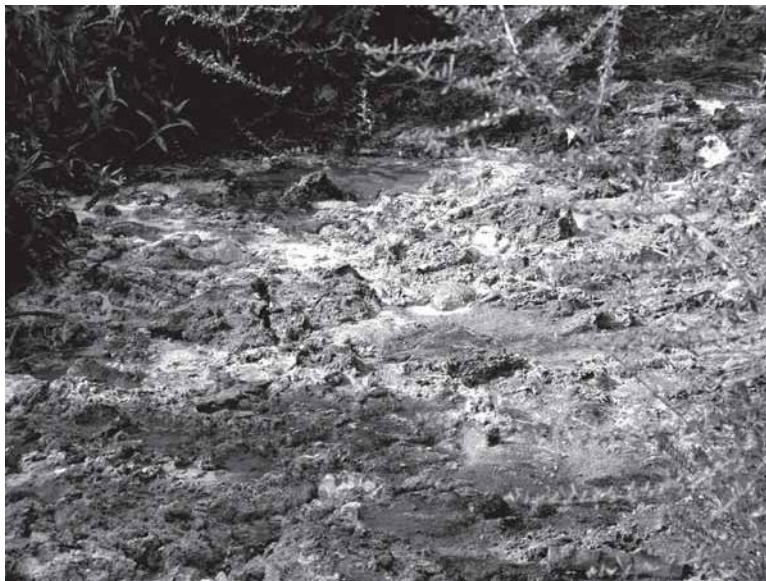
Figura 3. Acúmulo de gordura no canal em 13/9/2006.
