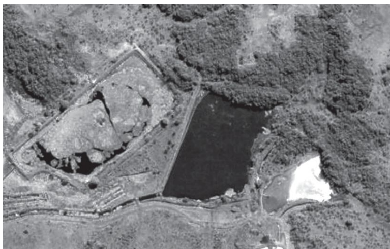
Figura 4. Sistema de tratamento de efluentes do frigorífico: 20/9/2006.
