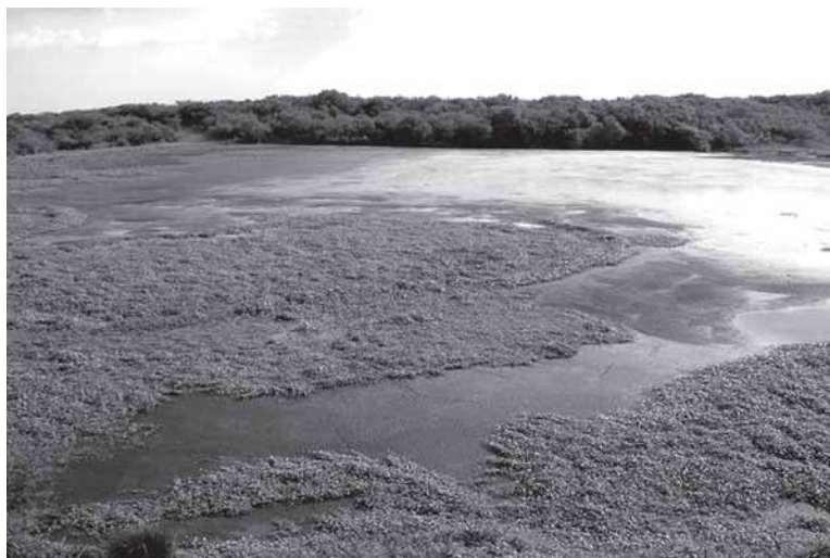
Figura 6. Lagoa facultativa assoreada pela sobrecarga: 26/9/2006.
