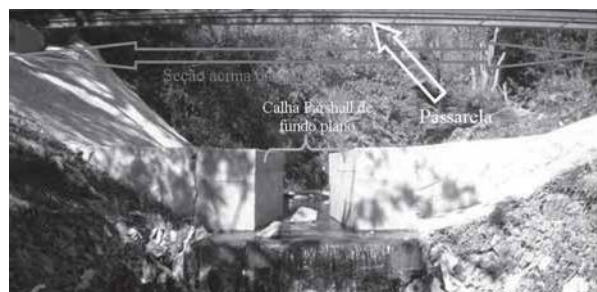
Figura 5. Perfil da estação fluviométrica, com detalhes da estrutura da passarela e da calha Parshall.
