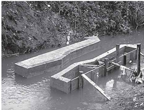
Figura 4. Estação fluviométrica em fase de construção.
