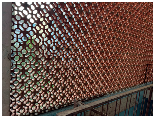
Figura 1 - Cobogós existentes no ambiente interno da Escola São Carlos, evidenciando características arquitetônicas originais da edificação
