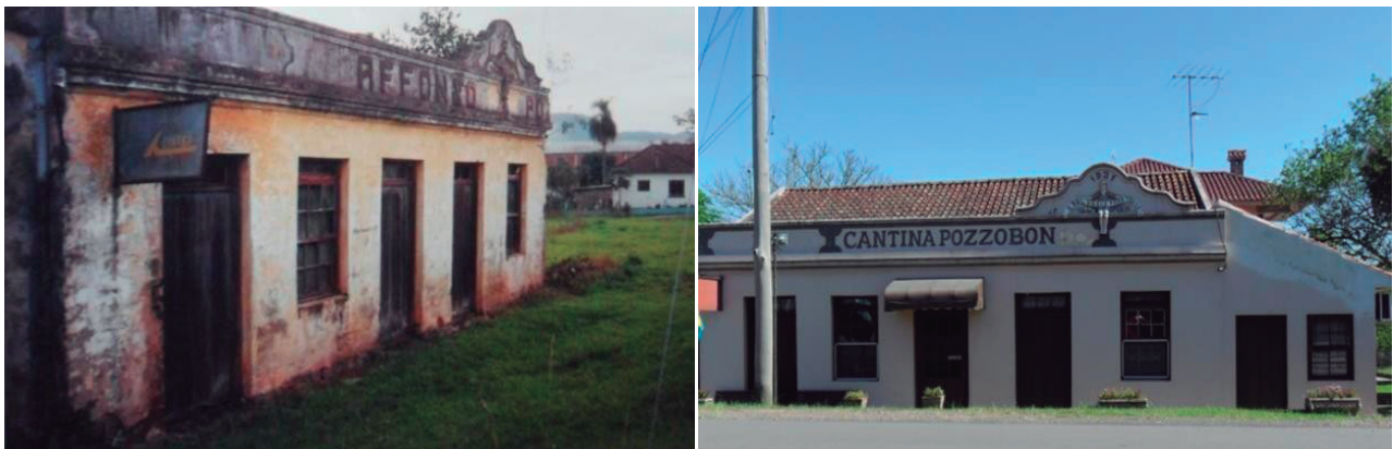
Figura 8 - Prédio do antigo e do novo - Cantina Pozzobon.
