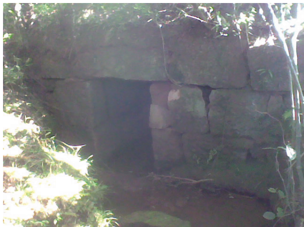
Figura 2 - Bueiro histórico localizado na Estrada Armando Arruda, nas coordenadas 29°37'25"S e 53°55'32"O.
