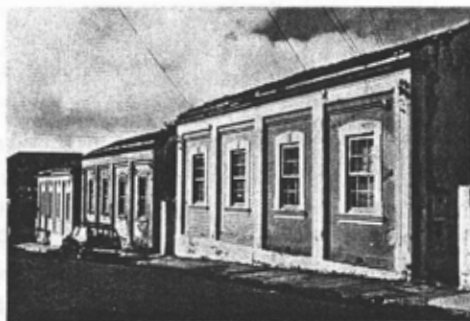
Figura 2: Residências da Rua Ernesto Beck, nº 2055 e 2045.
