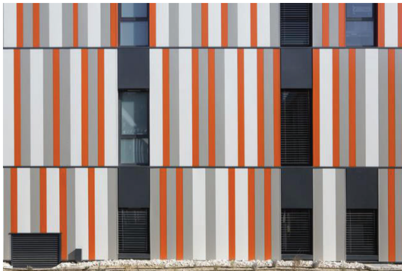
Figura 12 - Brise-soleil na cor laranja geram ritmo e movimento na fachada na escola Lycée Albert Einstein.
