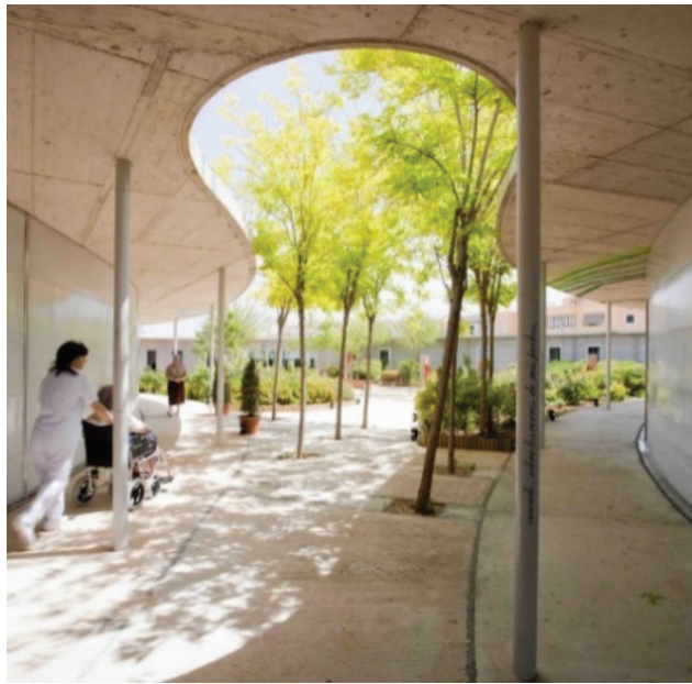
Figura 4 - Pátio interno do Santa Rita Geriatric Center , Illes Balears, Espanha.
