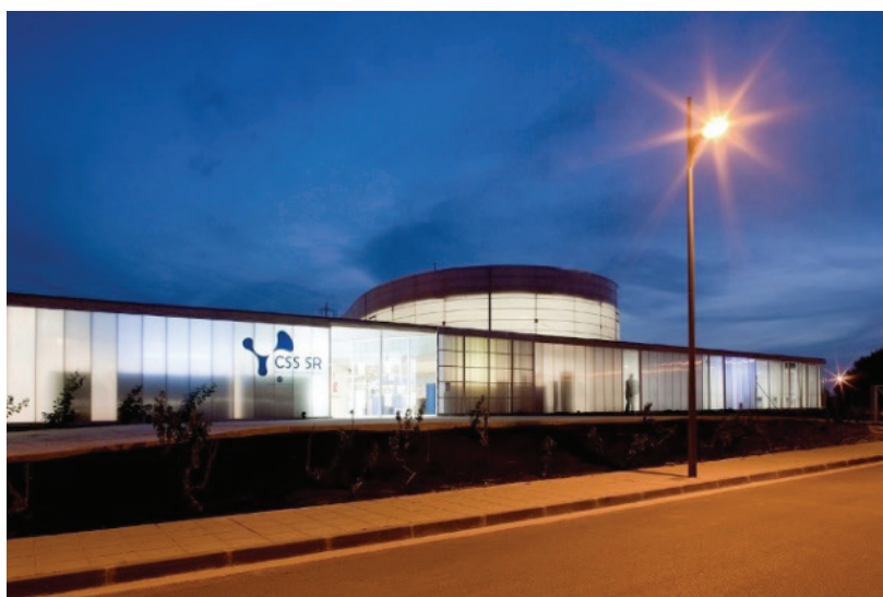
Figura 3 - Fachada externa do Santa Rita Geriatric Center , Illes Balears, Espanha.
