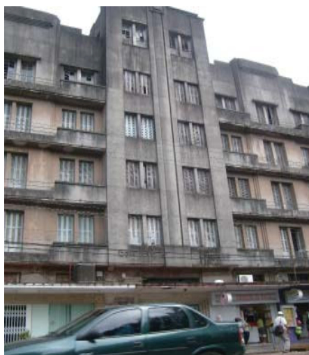
Figura 2 - Edifício Cauduro, situação atual.
