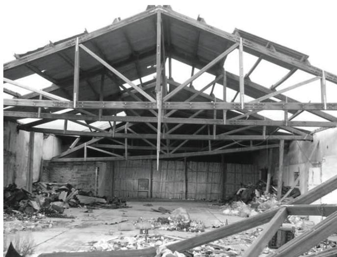
**Figura 4.** O telhado que desabou após um vendaval.
