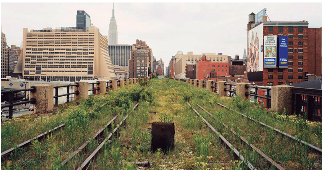
Figura 2 - Extensão High Line Park antes das obras.
