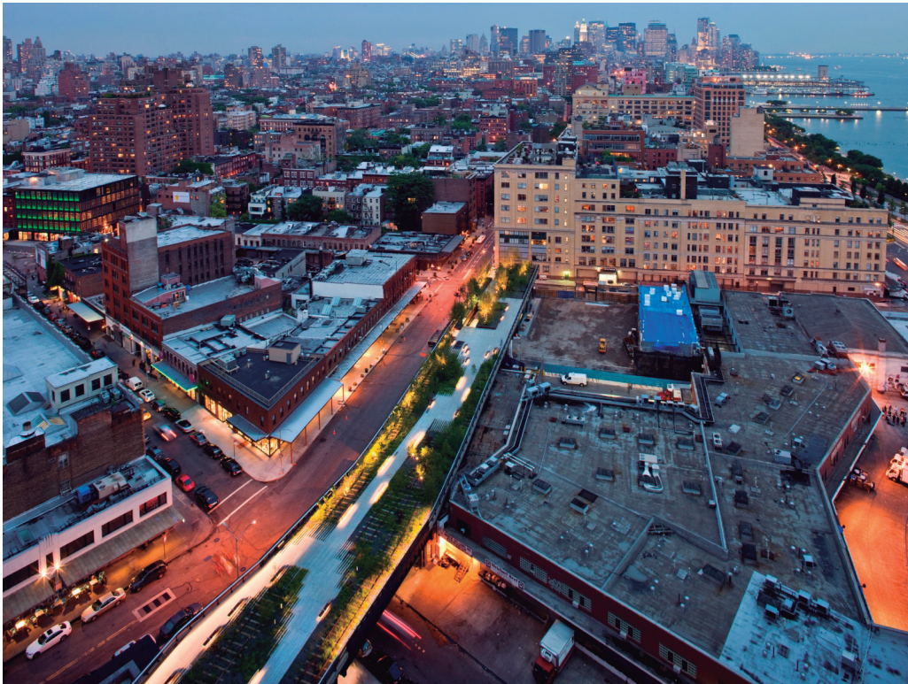
Figura 1 - Extensão High Line Park.
