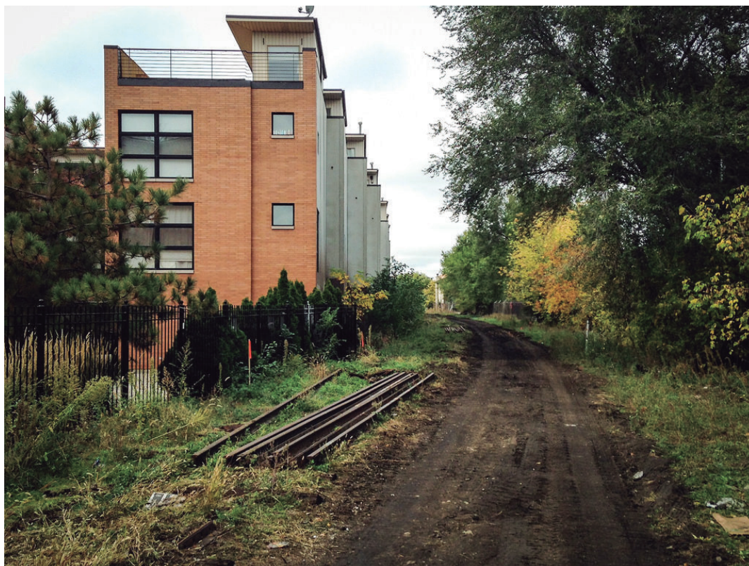
Figura 5 - Parque 606 antes das obras.
