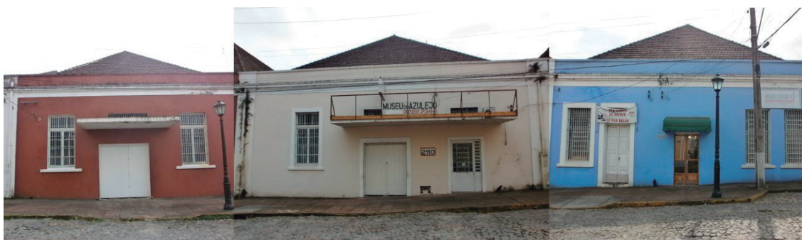
Figura 18 - Imagem das fachadas sul.
