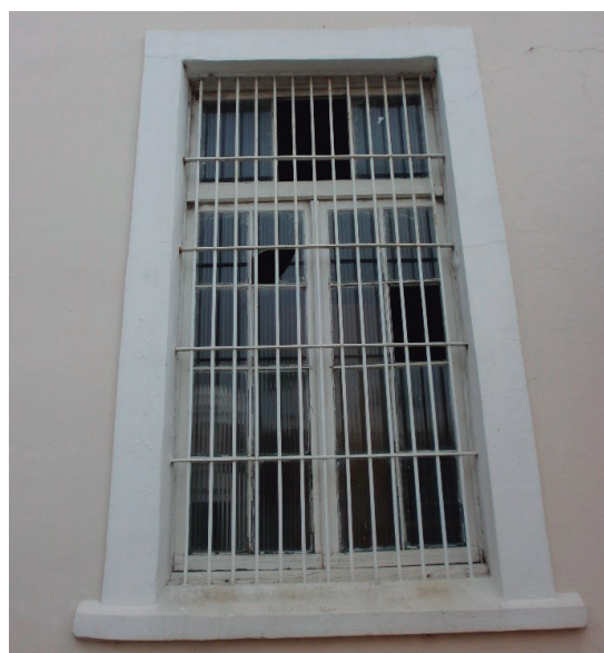
Figura 13 - Imagem mostrando uma janela da preexistência/armazém 2.
